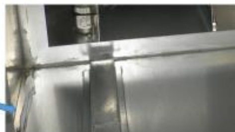
HEPA設置側の隙間 コーキング例
