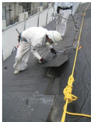
スレートの除去
