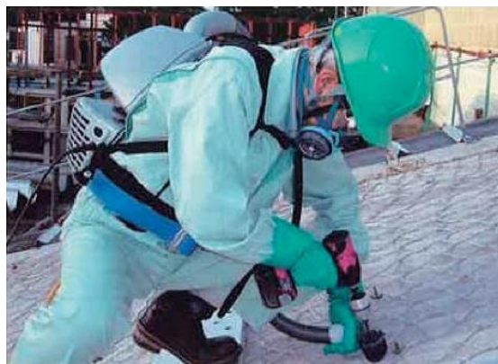
集じん回収（高性能真空掃除機）
